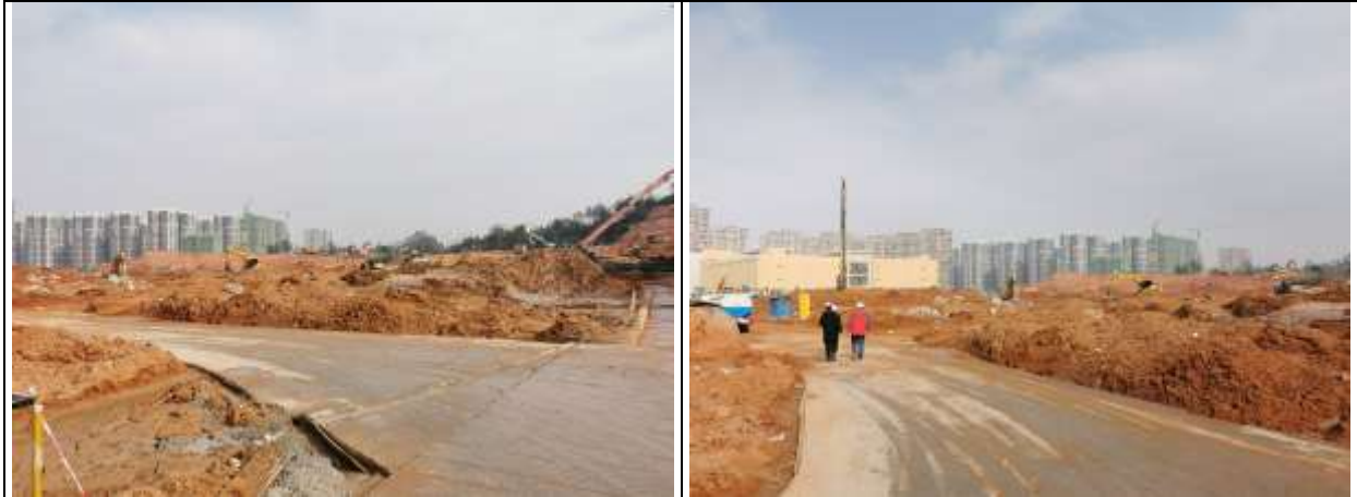
项目施工现状
